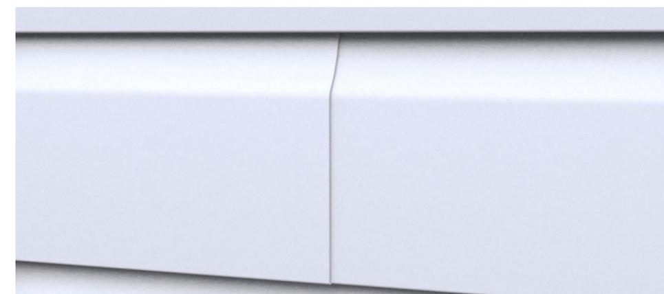
Jonction par recouvrement des lames
