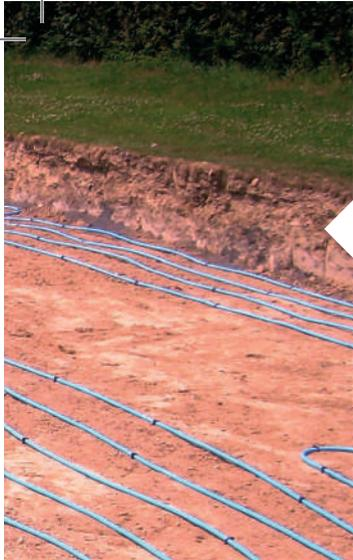
*Capteur horizontal de Géothermie*
